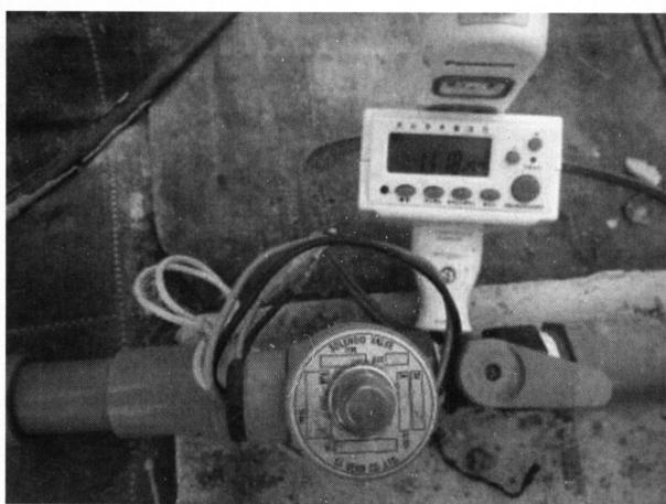
写真2. 電磁弁とウィークリータイマー
